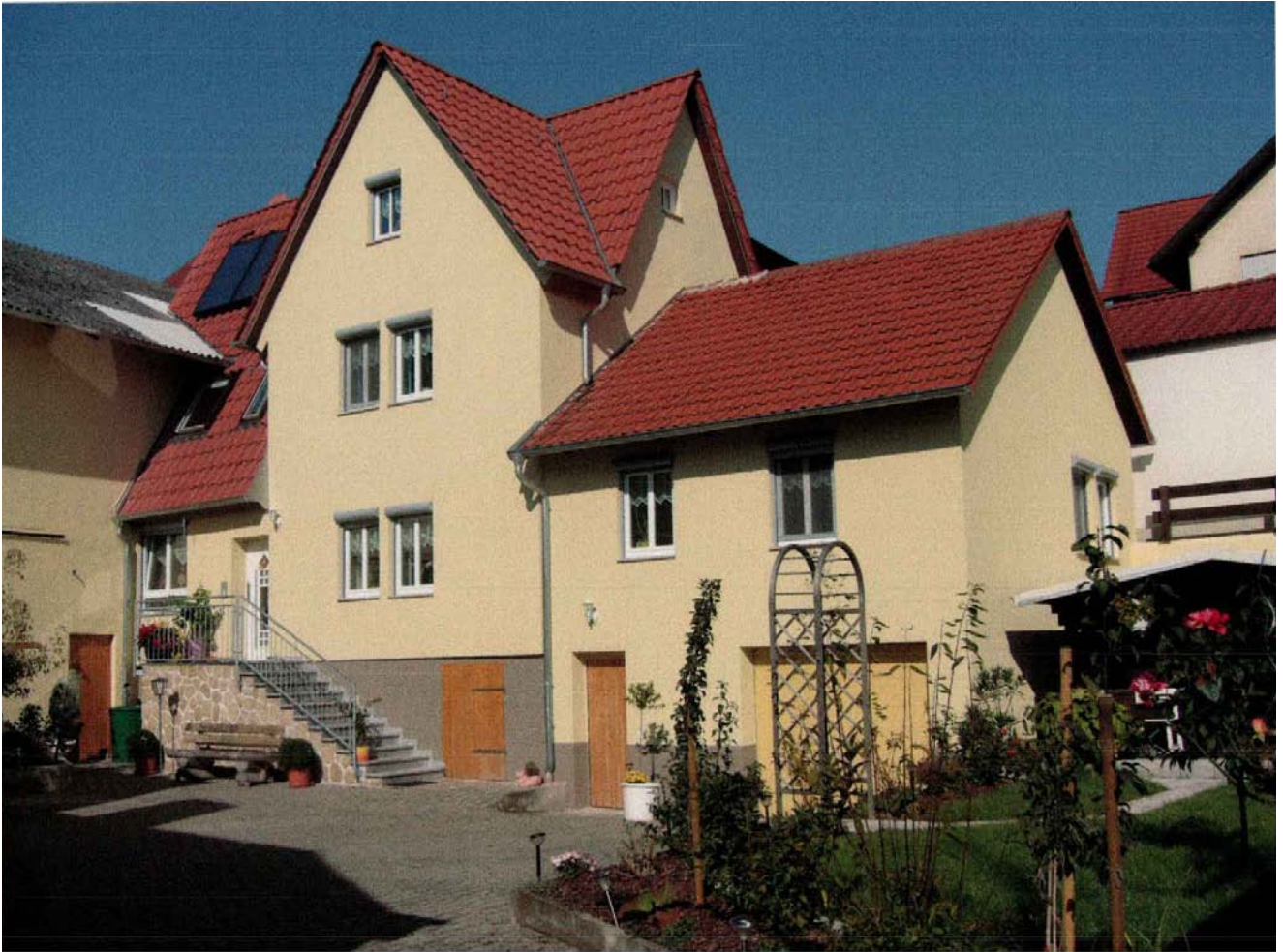
Modernisierung eines leer stehenden Wohnhauses
